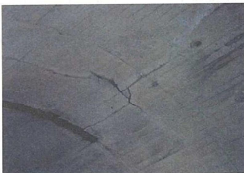
付写真-1.5 複数のひび割れで覆工コンクリートがブロック化している例
