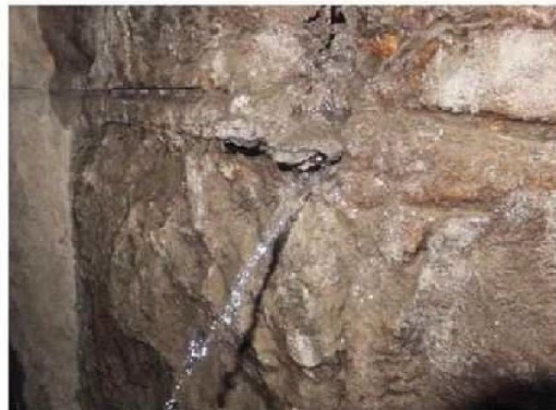
付写真-1.7 漏水（噴出）している例
