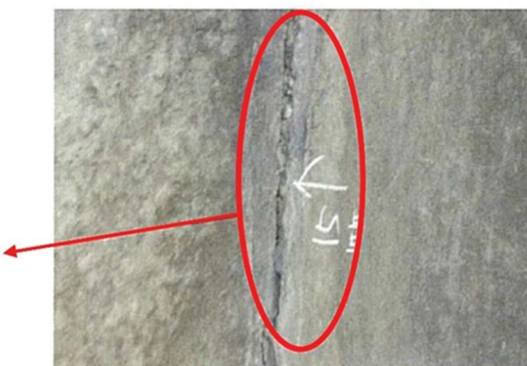
付写真-1.8 段差の例
