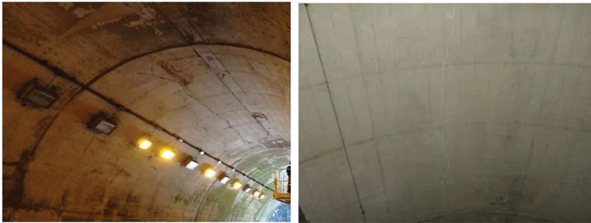
付写真-1.3 覆工の天端付近に発生した縦断方向のひび割れの例
