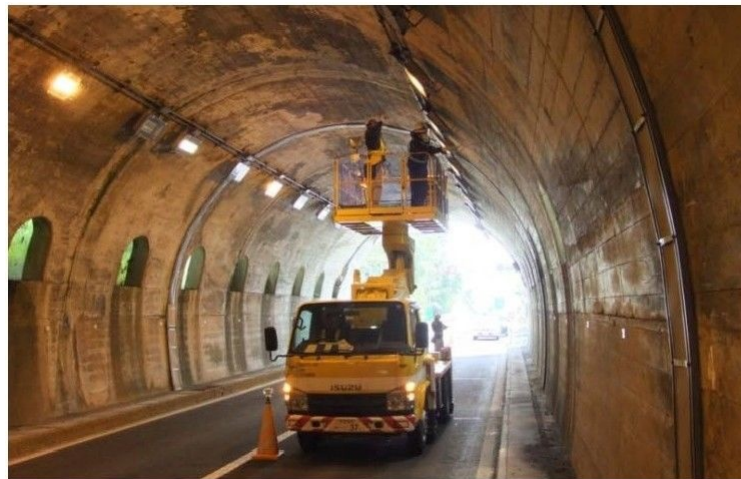
写真-解 6.1 近接目視作業状況
