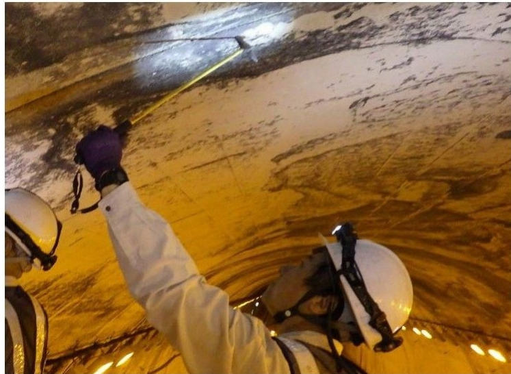
(a) トンネル本体工
