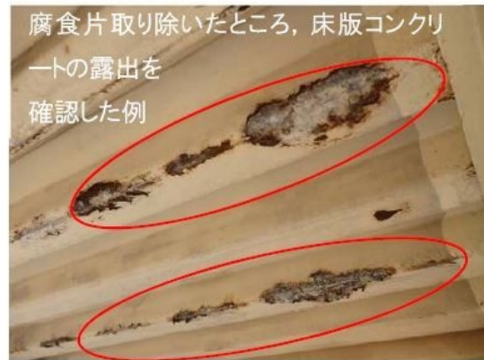
腐食片を取り除いた状態の例（床版）
