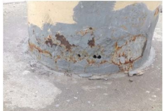
腐食片を取り除いた状態の例（下部）
