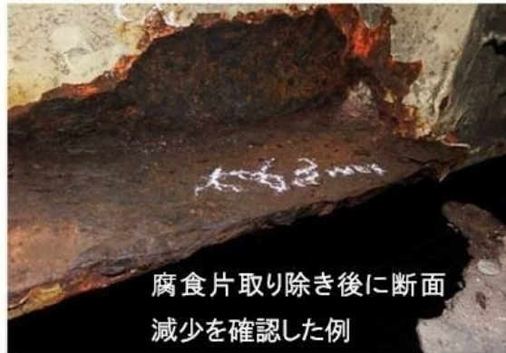
腐食片を取り除いた状態の例（主桁）
