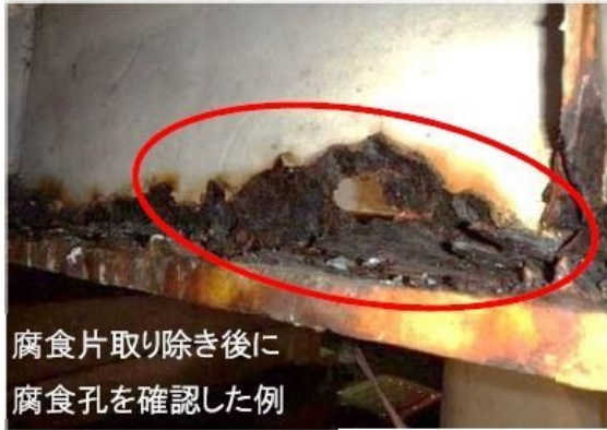
腐食片を取り除いた状態の例（主桁）
