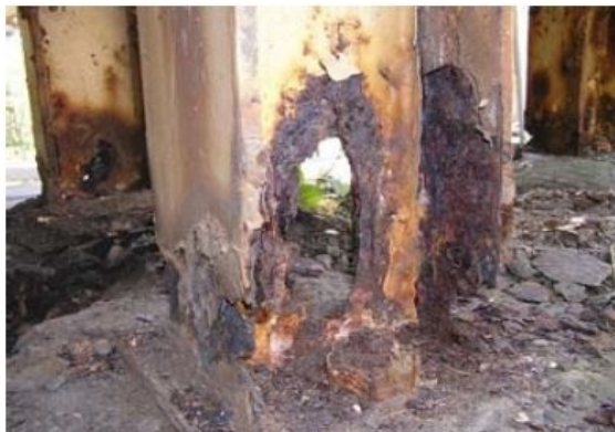
腐食片を取り除いた状態の例（下部）
