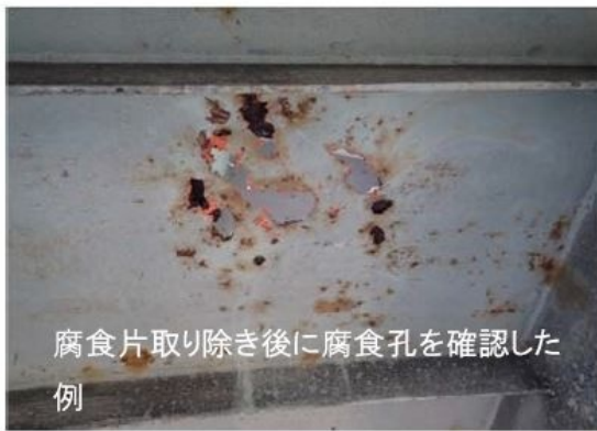
腐食片を取り除いた状態の例（床版）
