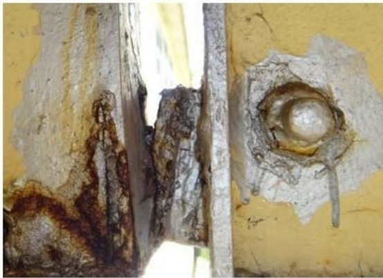
フックの溶接の状態 (接合部)
