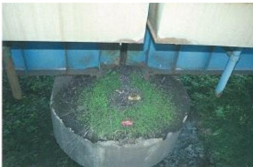
沓座に土砂が堆積している
