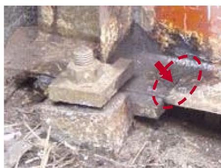
主桁下フランジのソールプレート前面に生じた亀裂又は塗膜割れ
