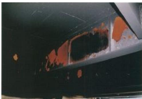
火災によって桁の構造性能の低下が懸念される
