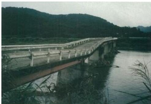
橋脚に沈下が生じている
