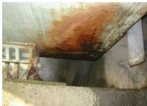
主部材で生じた局部的な表面錆程度の腐食であるが、水の侵入等により進行が速い位置で確認される
