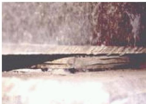
ゴムに劣化によるひびわれが生じている
