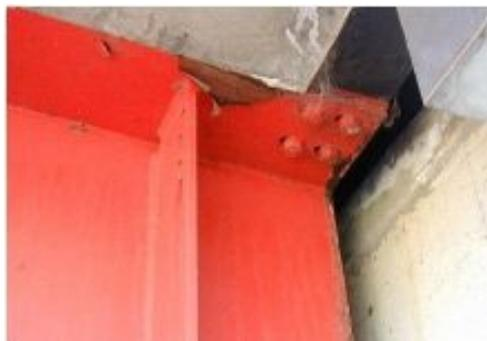
局部的に生じた表面錆程度の腐食や塗装劣化
