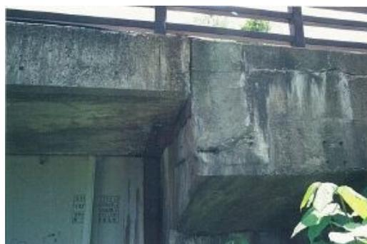
桁と胸壁が接触しており、
