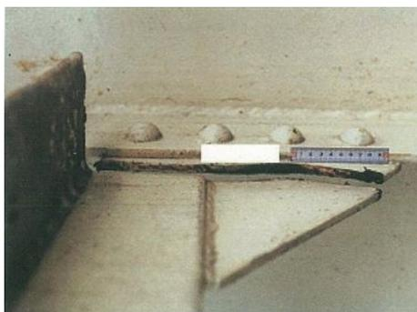
対傾構の破断
