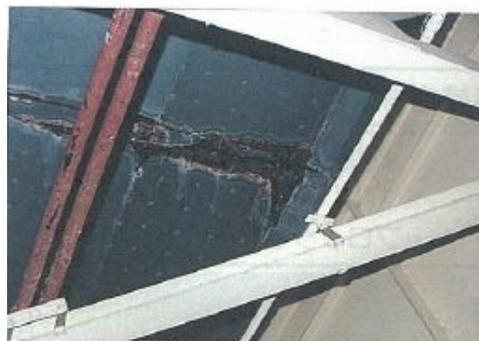
鋼板の断面減少が生じている
