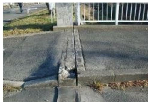
二次部材において安全性を損なわない程度の局所的な変形・欠損が見られる
