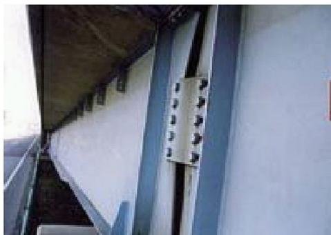
鋼主桁に変形が生じている
