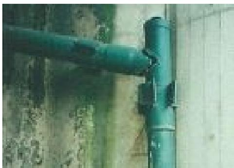
プラスチックが劣化により破損しており、漏水により主部材
