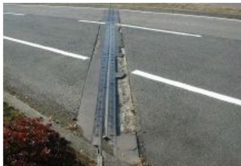
伸縮装置の後打ちコンクリートに著しい欠損が見られる
