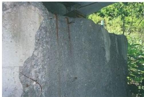
凍害の恐れのある断面欠損
