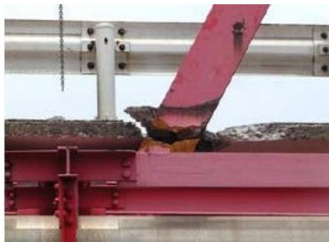
トラス橋の斜材の破断
