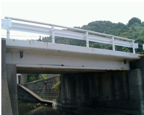
広範囲で補修材（保護塗装）のひびわれが生じている
