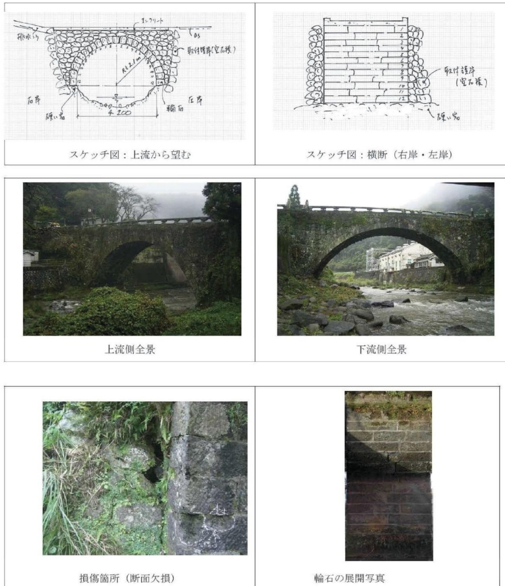
図 3.3.2 石橋の損傷スケッチと写真撮影
