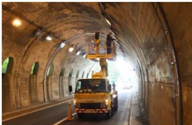
写真一解 3. 1 近接目視作業状況
