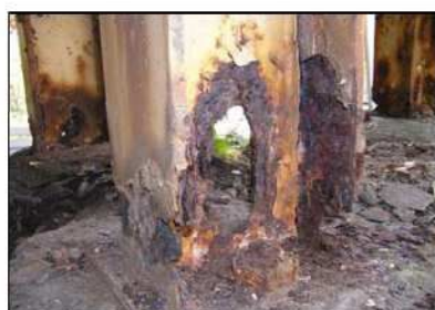
腐食片を取り除いた状態例(下部)
