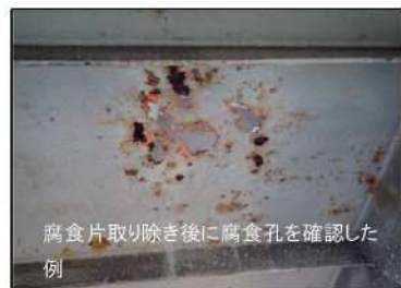
腐食片を取り除いた状態の例 (床版)
