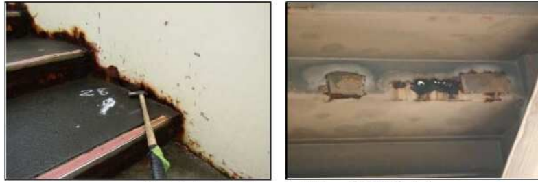
腐食片を取り除いた状態の例(階段部)
