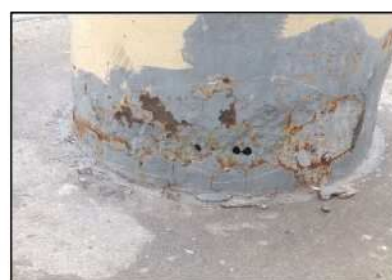
腐食片を取り除いた状態例(下部)
