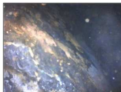
地覆内部で滞水を確認：波板側面腐食状況
