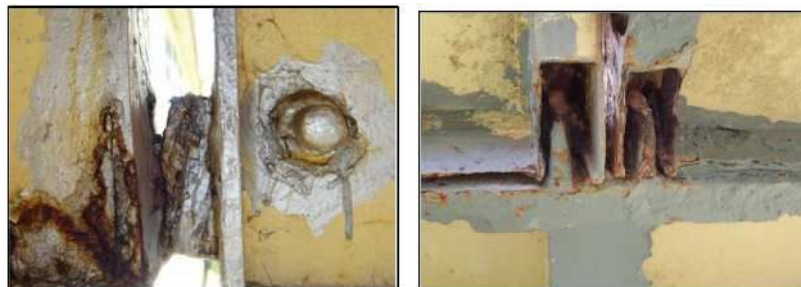
フックの溶接の状態 (接合部)
