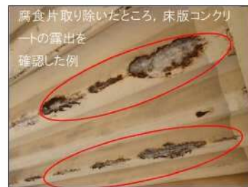
腐食片を取り除いた状態の例 (床版)
