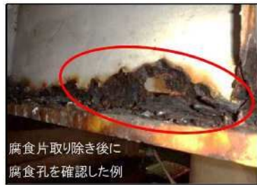
腐食片を取り除いた状態の例(主桁)
