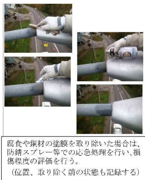
図－8. 2. 1 点検時に応急処置を行った状況例
