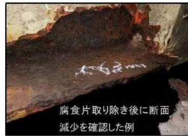
腐食片を取り除いた状態の例(主桁)
