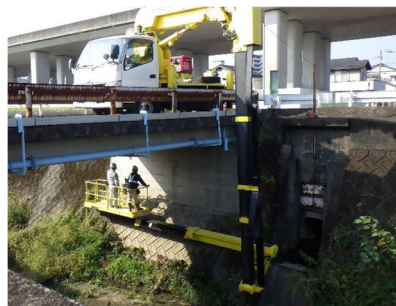
橋梁の点検状況
