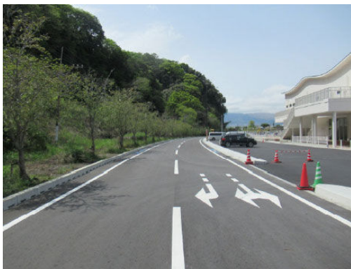
市道 白木田ノ浦線（令和5年度施工）
