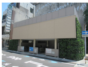
府内3号線地上機器集約設置箇所 (1F 駐輪場 2F 地上機器設置箇所)
