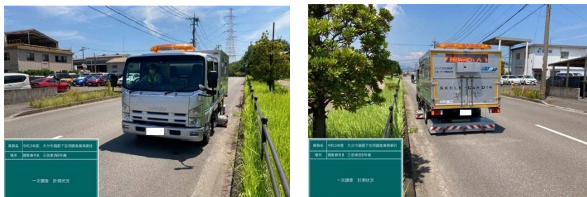
路面化空洞調査
