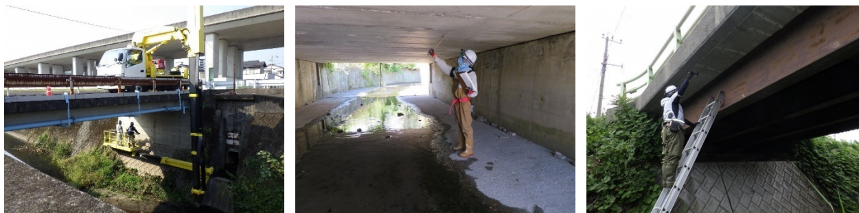
橋梁の点検状況
