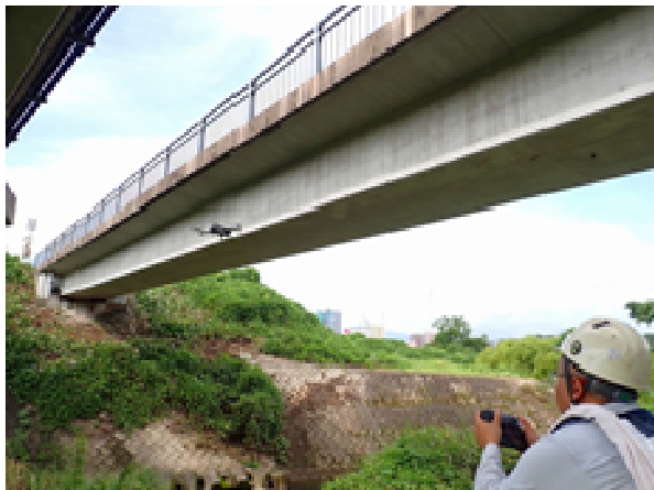
ドローンによる点検状況
