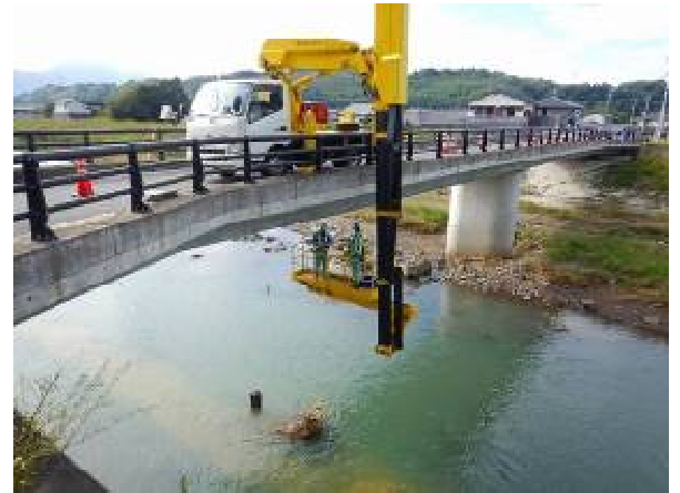
点検車による点検状況
