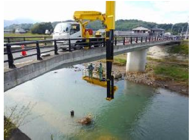
点検車による点検状況
