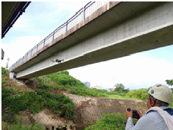
ドローンによる点検状況
