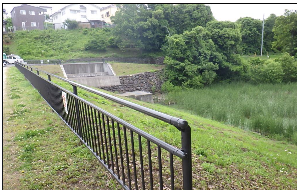
光吉谷川流量調整施設
