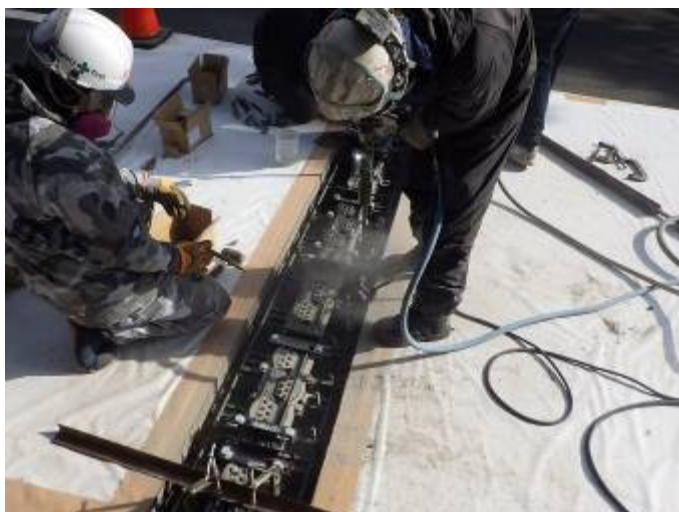
橋梁等維持改良事業 白銀橋 伸縮装置施工状況
