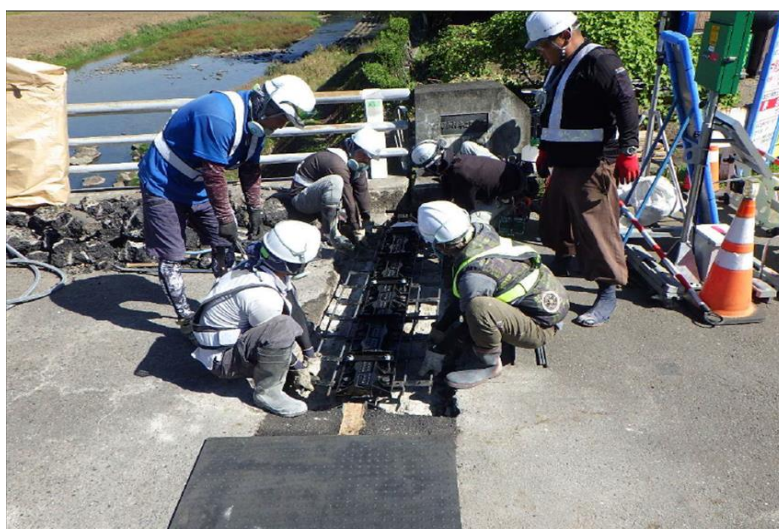
橋梁等維持改良事業 作業中（伸縮継手の更新）
