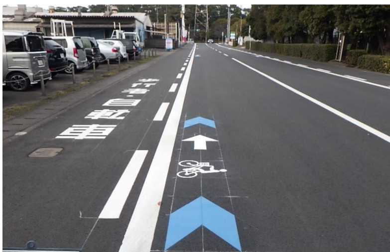
交通安全対策事業 新貝新栄町2号線
