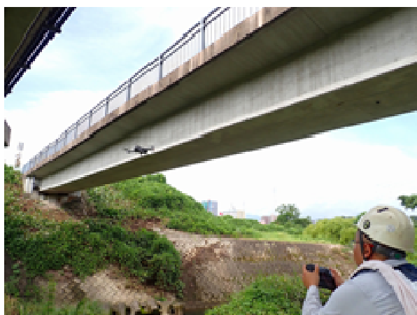
ドローンによる点検状況
