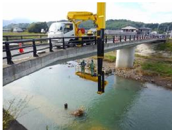
点検車による点検状況
