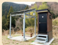
安田駐車場にある パイオトイレ。
