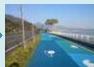
国道10号自転車・歩行者道
