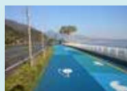
国道10号自転車・歩行者道
