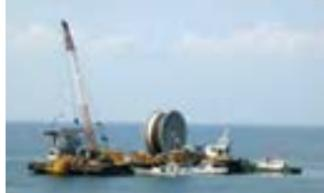
送水管やケーブルを設置する場合は波浪などからの障害を防ぐため海底面に埋める必要がある。同社は従来から自動埋設機を利用しており、海底の汚濁防止や工期短縮に貢献している。
