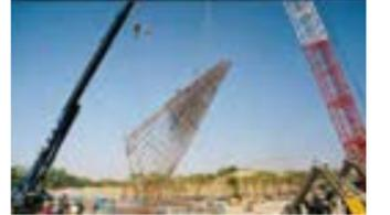
建物の主要部分となる柱や梁(はり)などをユニット化することで、現場での組み立て作業の効率化、省力化を実現。高所作業を減らすことができるので、安全性の確保にもつながっている。
