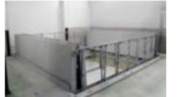
防水板に続く自社開発製品がマシンハッチ。通常は床として使用し、機器の搬出入などで開口が必要になった場合に開閉が出来る床ハッチ。大開口部、耐水、耐火、防水など様々な設計条件に対応する。ごみ処理施設や鉄道、道路建設に係る施設などでの使用を想定する。
