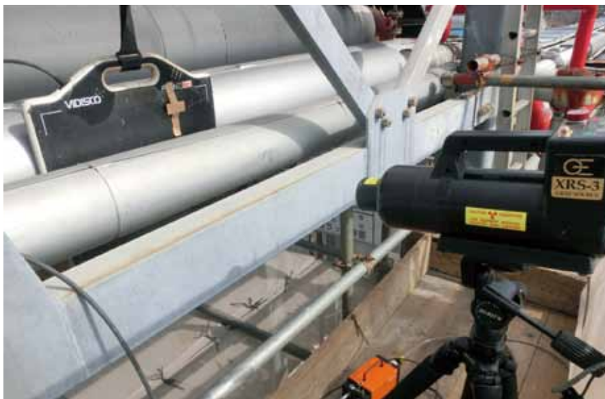
構造物の傷や劣化を非破壊検査で調査する
