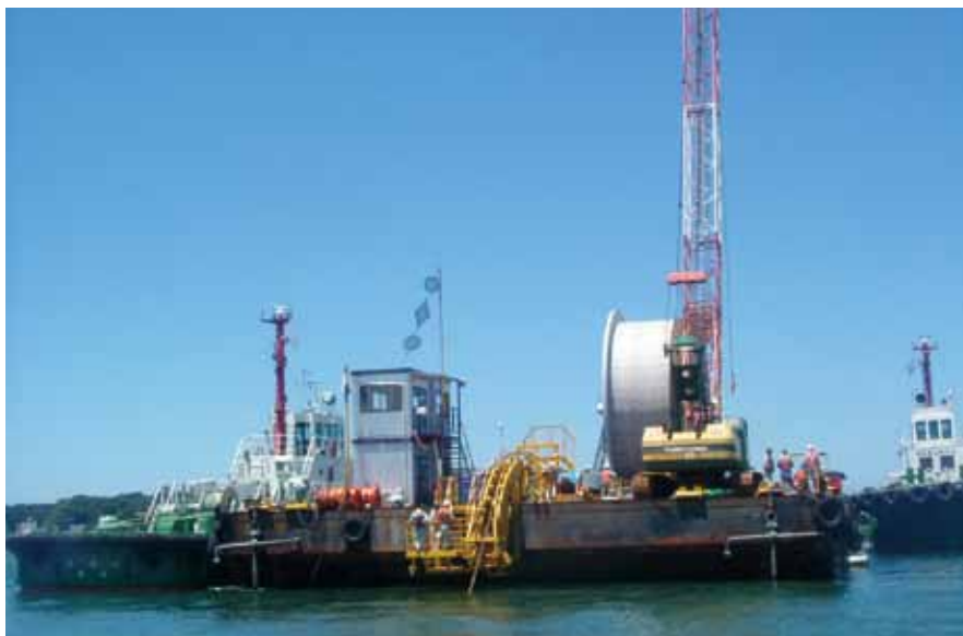
海上で海底送水管や海底ケーブルの布設工事を行う
