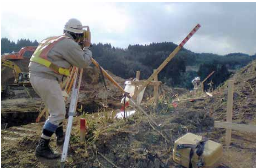
独自の支援ツールで工事測量現場をサポート
