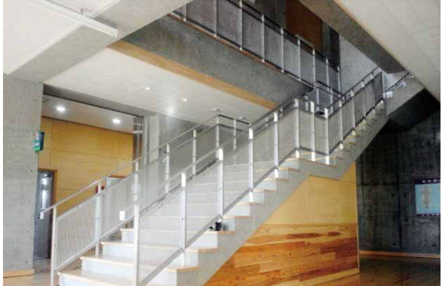
学校の階段の手すり
