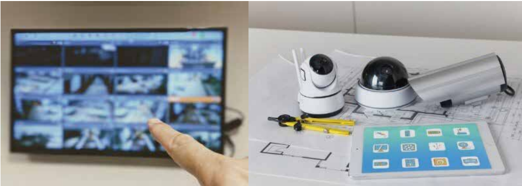
店舗イメージ(各店舗にカメラ・モニター設置し、34店舗の様子を順番に表示)また、入口やエレベーター前などの共用部にも各店舗の様子が全体で見える大型モニターを設置。
