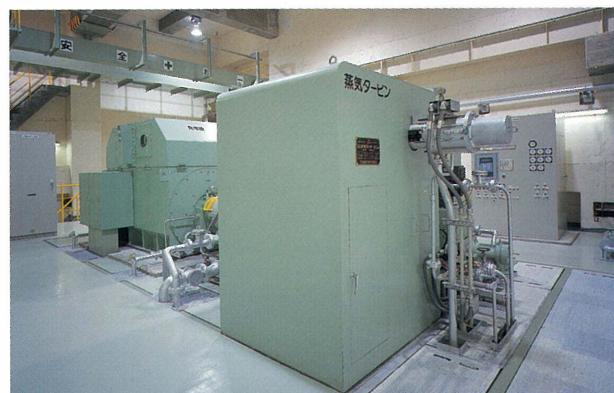
ポイラーで作られた蒸気を利用して発電を行います。余った電気は電力会社に送られます。
