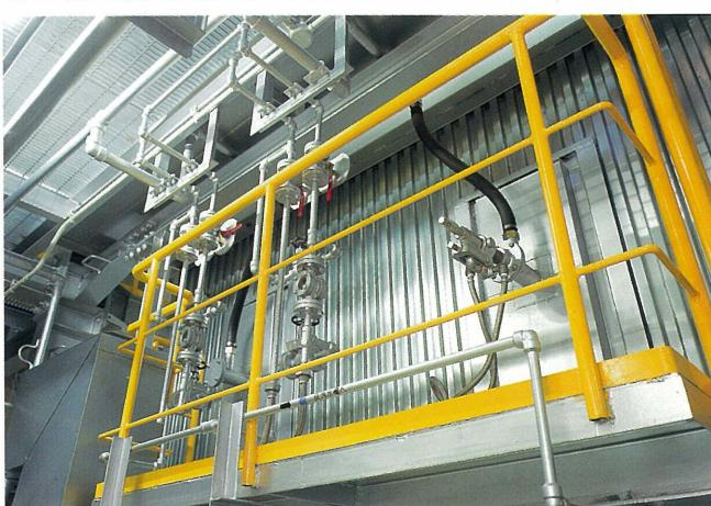
排ガス中の窒素酸化物を除去するために尿素水を炉内に噴霧しています。
