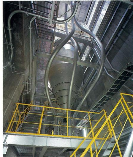
排ガス中に消石灰及び反応助剤を噴きつけて有害ガス成分と反応させ、バグフィルターで反応物をとり除きます。
