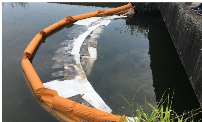
オイルフェンスの設置状況
