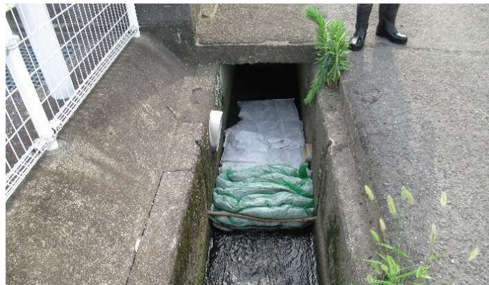
オイルマットの設置(側溝)
