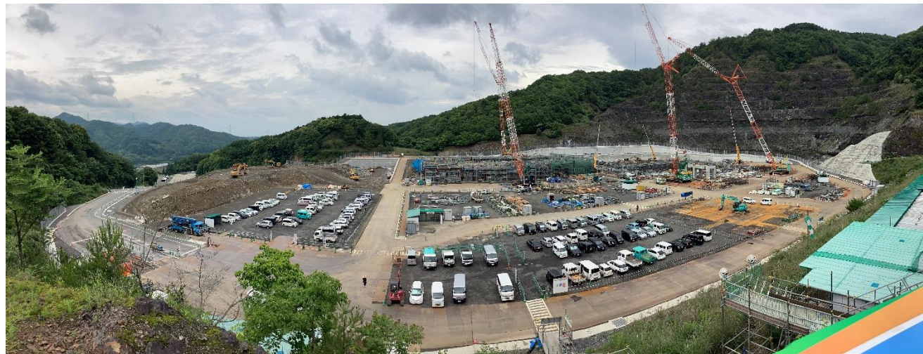
①焼却施設：鉄筋型枠工事・リサイクル施設：鉄筋型枠工事
