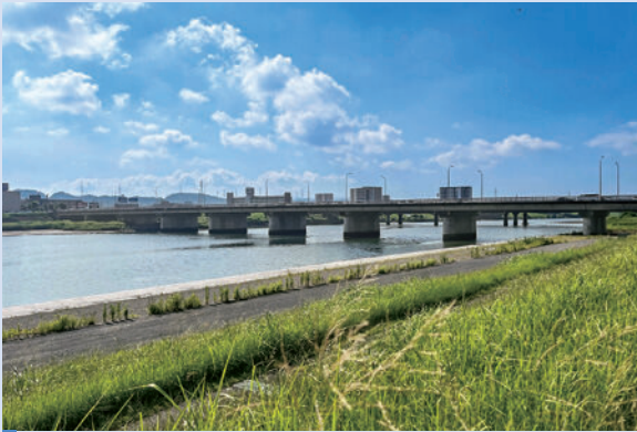
(写真：大分川 [濁尾橋])
