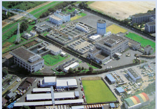
(写真：① 古国府浄水場)
