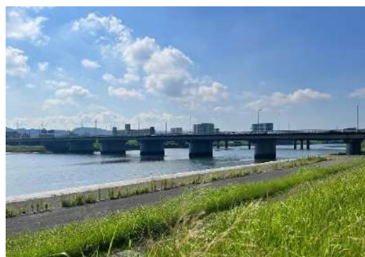
河川調査地点例(滝尾橋)
