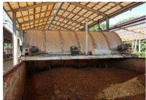
畜産農家の堆肥処理施設
