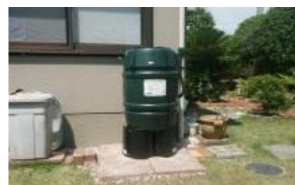
雨水貯留施設
