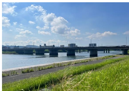
河川調査地点例(滝尾橋)
