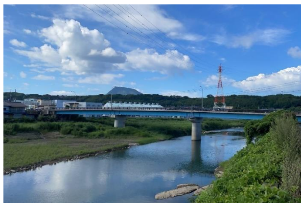
河川調査地点例(天神橋)
