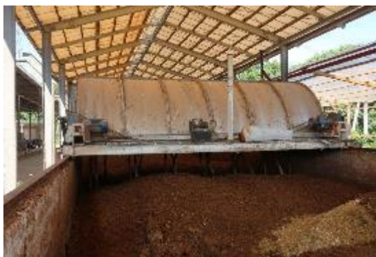
畜産農家の堆肥処理施設
