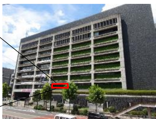
市役所本庁舎南側外観
