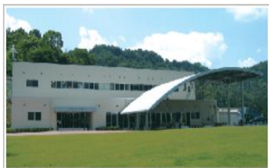
大分エコライフプラザの外観
