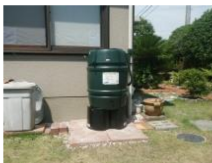
雨水貯留施設
