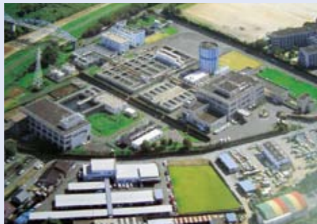
(写真：① 古国府浄水場)
