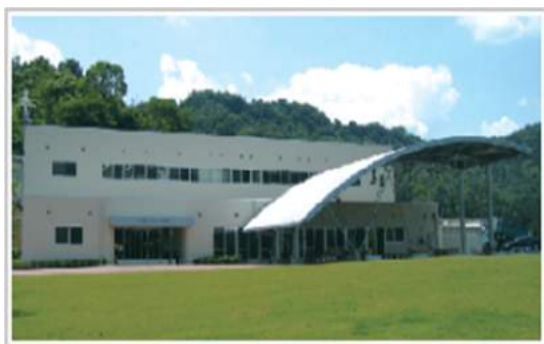
大分エコライフプラザの外観
