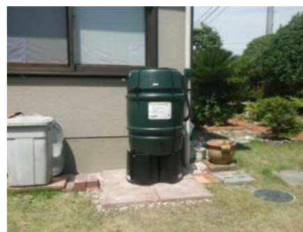
雨水貯留施設
