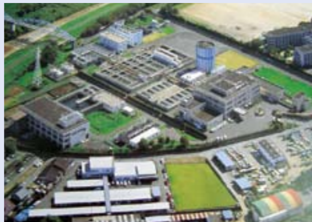
(写真：① 古国府浄水場)
