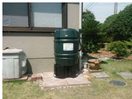
雨水貯留施設
