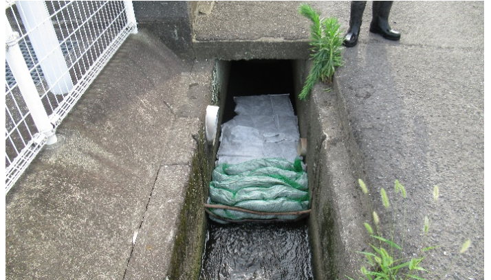
オイルマットの設置(側溝)
