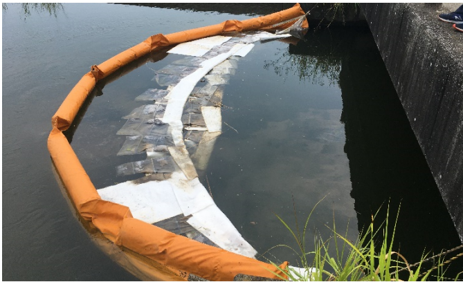
オイルフェンスの設置状況
