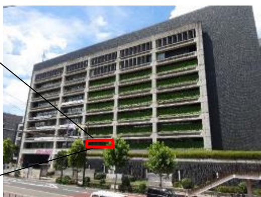
市役所本庁舎南側外観
