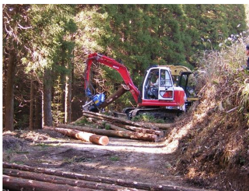
高性能林業機械による間伐
