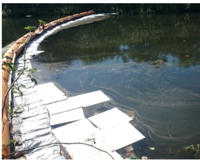
河川でのオイルフェンス設置状況
