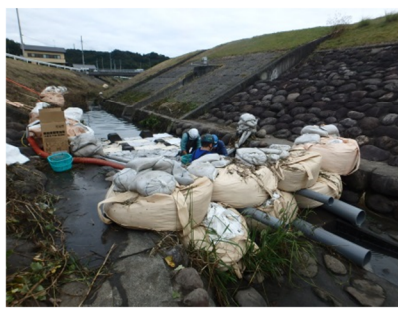
油の回収状況
