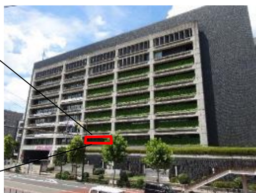
市役所本庁舎南側外観
