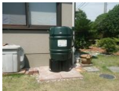
雨水貯留施設
