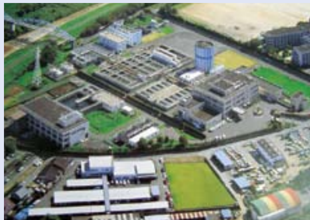
(写真：① 古国府浄水場)
