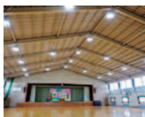
LED照明 (田尻小)
