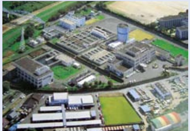
(写真：① 古国府浄水場)
