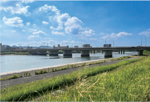
(写真：大分川 [濁尾橋])
