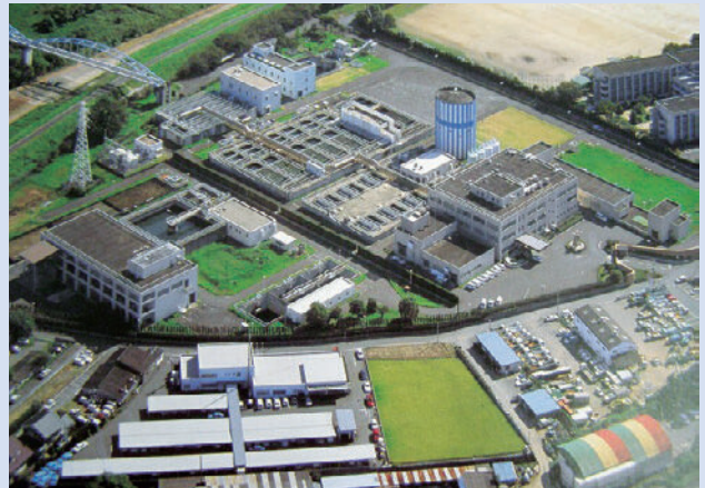
(写真：① 古国府浄水場)
