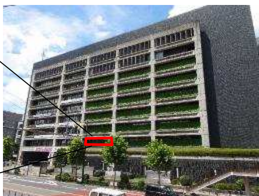
市役所本庁舎南側外観
