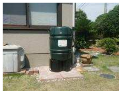
雨水貯留施設
