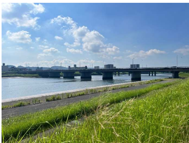
河川調査地点例（滝尾橋）
