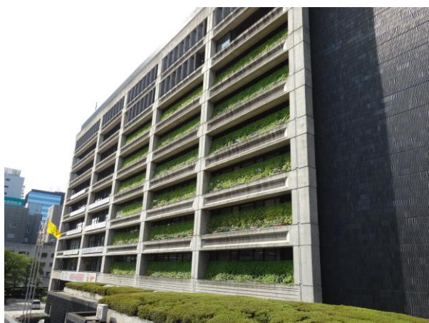
市役所本庁舎南側の緑のカーテン
