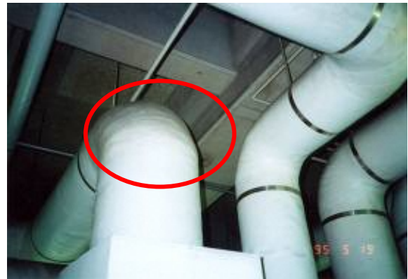
保温材（配管等）
