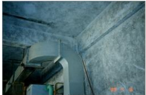
機械室の壁・天井の断熱
