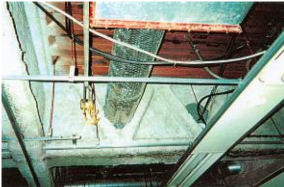
鉄骨造の梁・柱の耐火被覆
