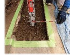
モルタル塗り作業
